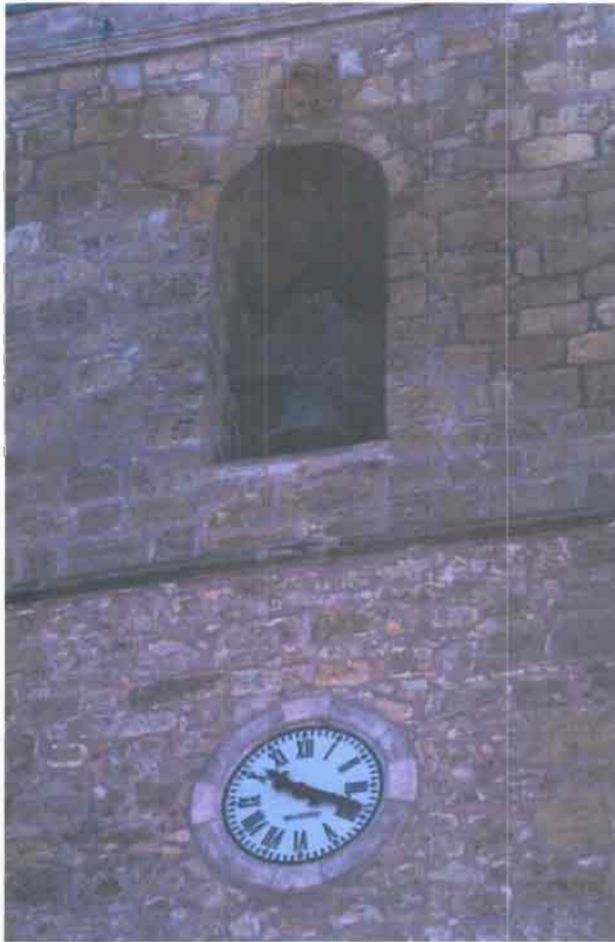
Fot. 1.- Campanario. Detalle. Iglesia de San Sebastián. Munera.
