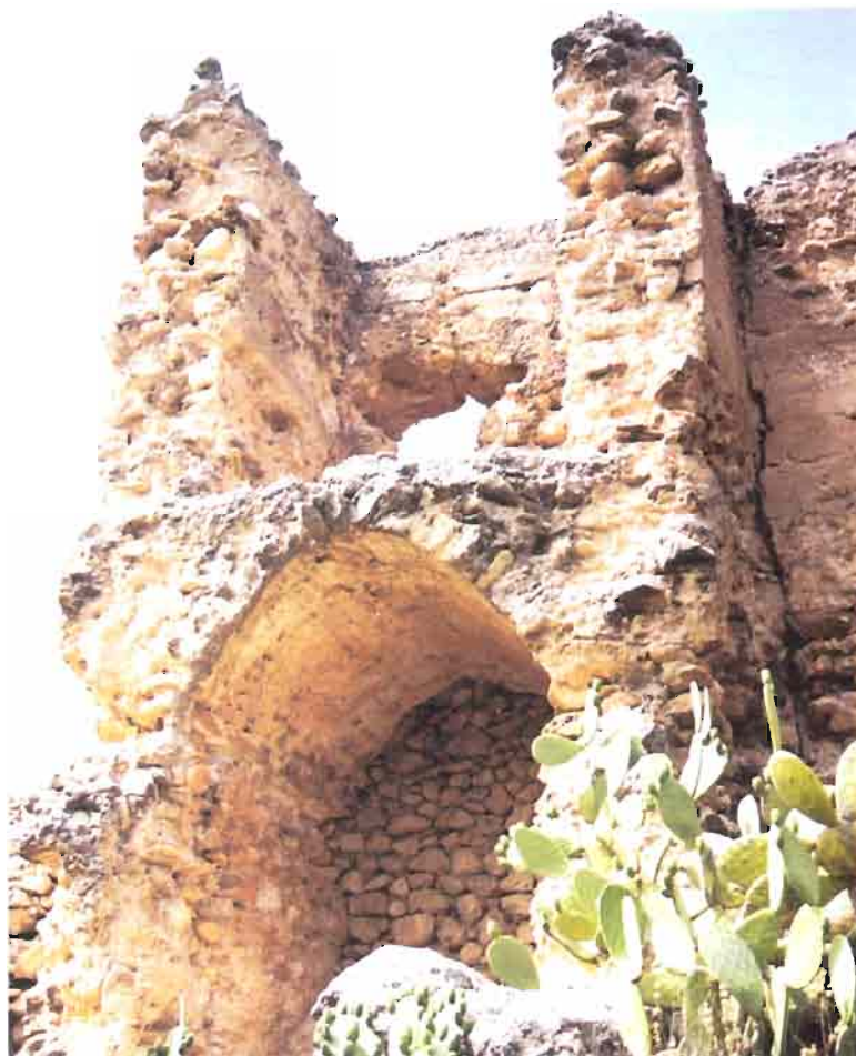
LÁMINA XXV.- Puerta-torre sur o acceso principal al interior del recinto externo del castillo.
