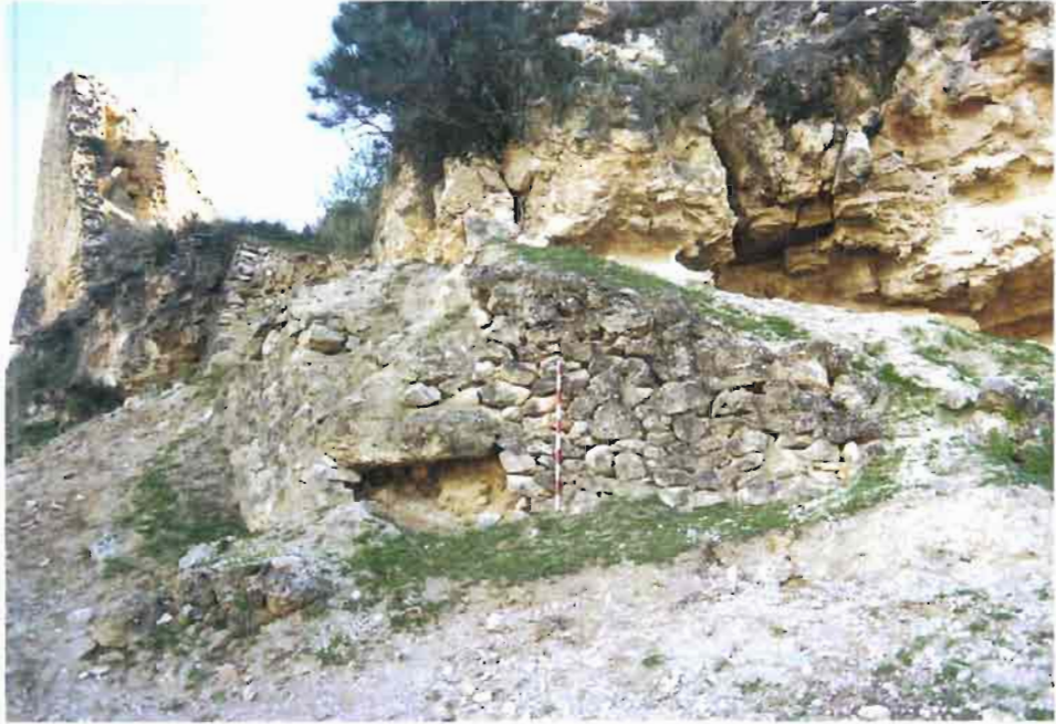
LÁMINA XXXII.- Vista general de la escalera de acceso al recinto interno.
