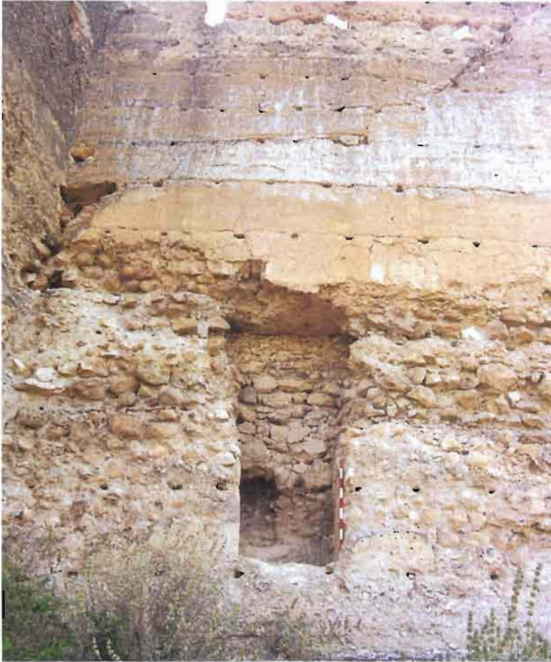
LÁMINA XXVII.- Posible puerta en la zona este del recinto externo.
