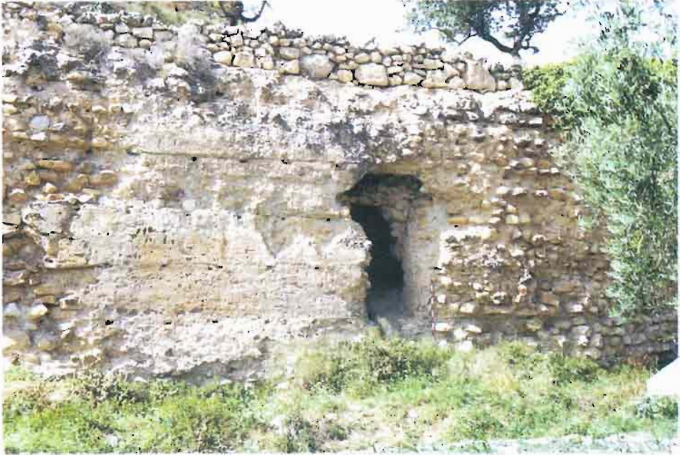
LÁMINA XXVI.- Posible puerta en la zona sur del complejo fortificado.
