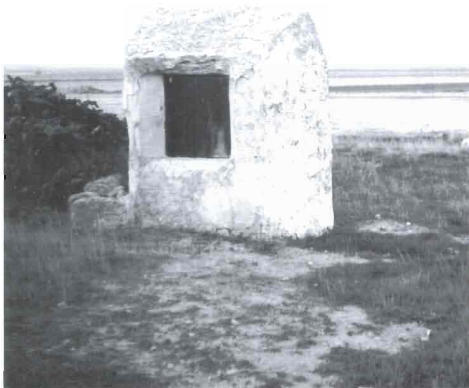
5.4 Pozo a dos aguas con cubierta de mampostería.
