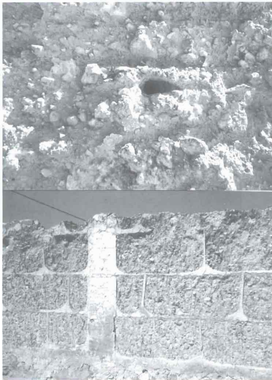
1.3 Agujal y muro de tapial de brencas con machón.
