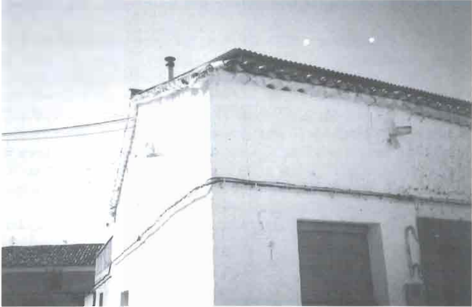
1.4 Tirantas aspadas en la confluencia de dos muros (Casas de Ves).
