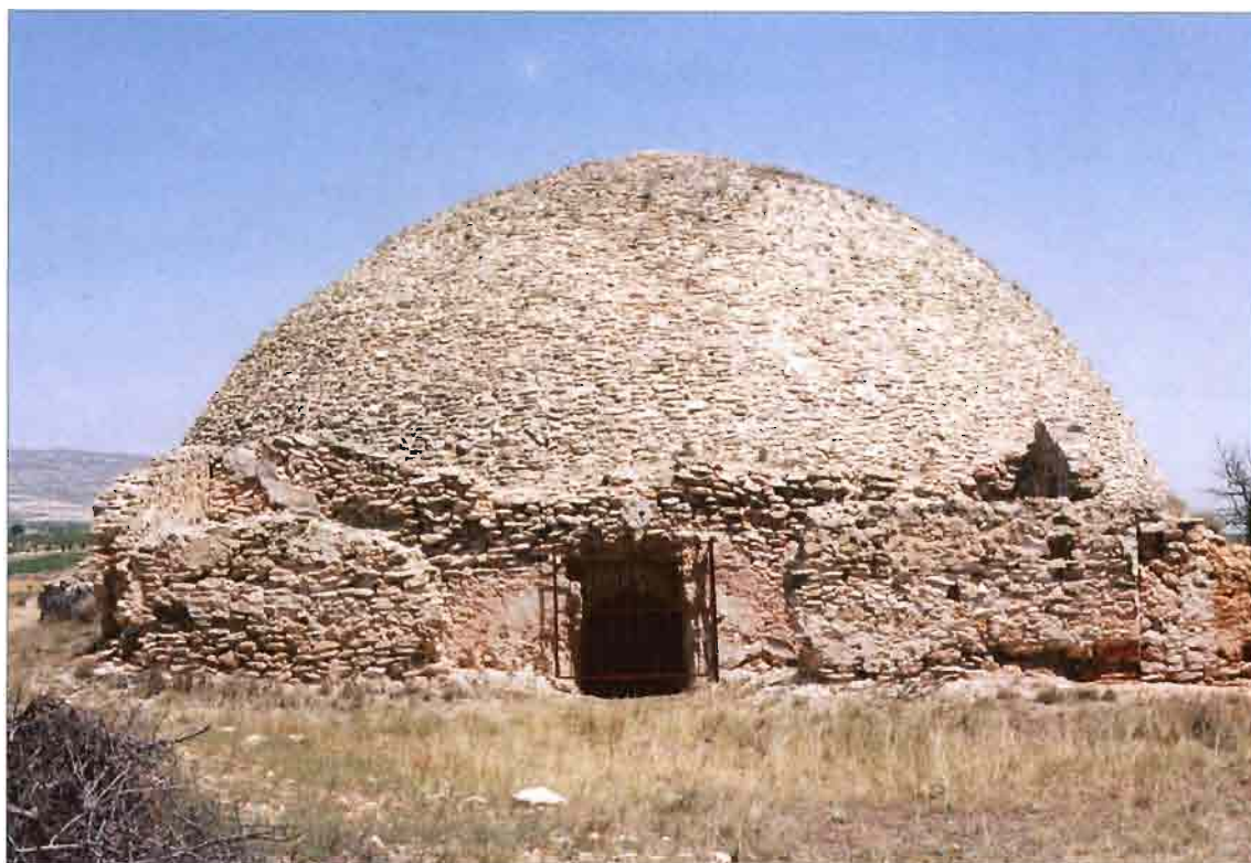
Foto 1 ► Vista del pozo y de los restos de la casa adosada
