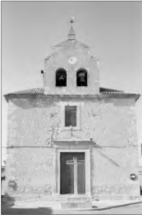
Iglesia de Casas de los Pinos, Cuenca. Fachada tipo cara. Foto: Javier García Bresó, 1999.
