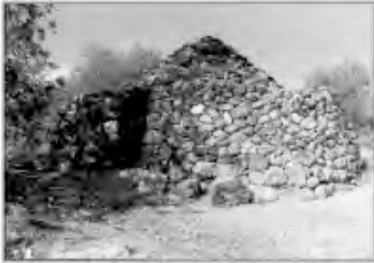
Foto 5.- Cuco Amparo Pérez Sánchiz. Situada en La Rocha, es de tamaño mediano, y tal vez donde la reconstrucción ha sido, junto con el Cuco de Miguel G. Bleda, de los más espectaculares por la diferencia entre el principio y el resultado final. El muro que vemos en primer plano estaba casi todo en el suelo, por lo que la intervención era absolutamente necesaria.
