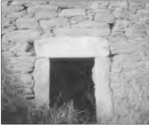
Fig.1: Jambas y dintel de un chozo.
