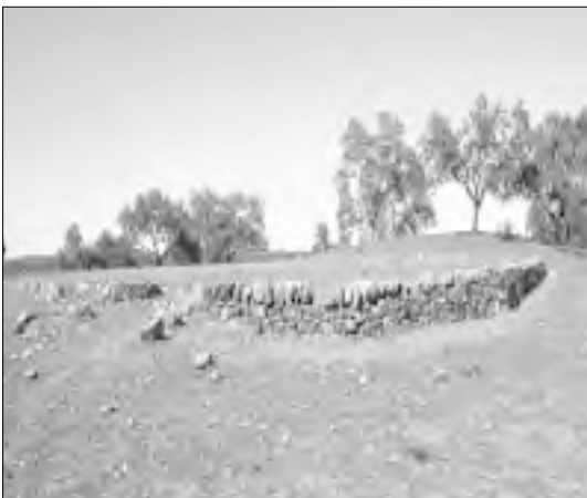
Foto 2. Muro de contención de una era en la provincia de Huelva.
