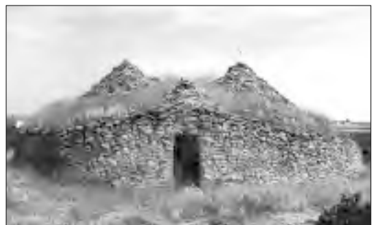
Foto 3.- Construcciones de plantas complejas
