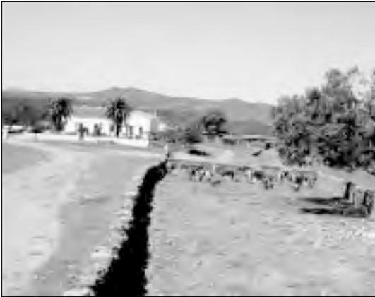
Foto 1. Cercado de división para ganado realizado en piedra seca en un cortijo del Andévalo (Huelva).
