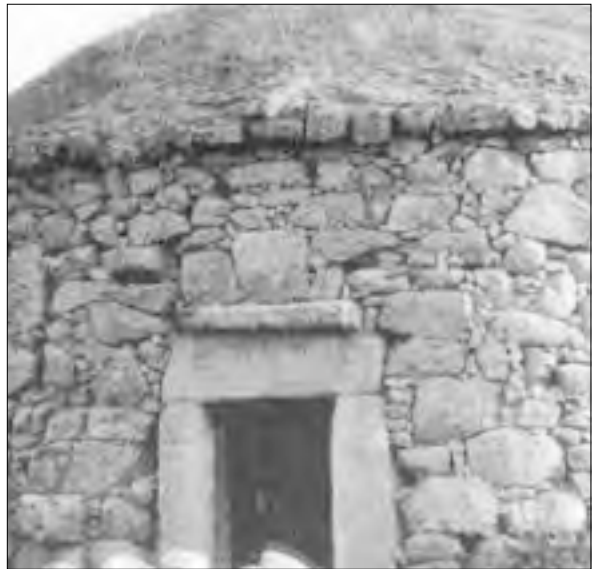
Fig.4: Detalle de visera por encima del dintel.
