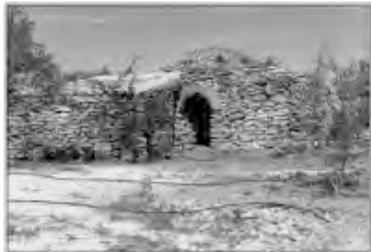
Foto 8.- Cuco de Teresa Francés. Está situado frente al cuco anterior, en la partida del Pelao. Es de destacar su anexo para bestias de carga, separada del cuerpo central del cuco. En su interior encontramos chimenea, banco rodado para el asiento de las personas, y un armario. En su exterior hay una escala para acceder al tejado.
