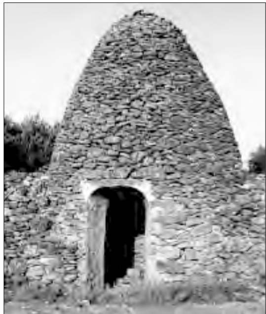
Foto 4.- Construcciones de planta circular
