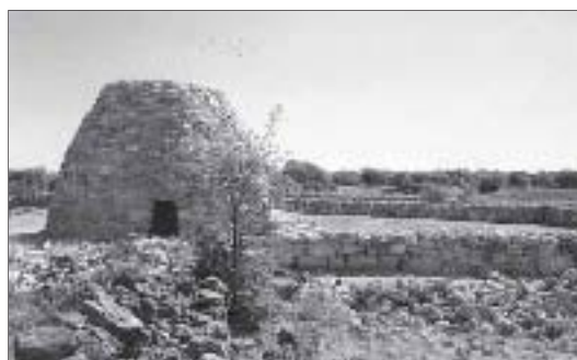
Foto 6.- Vista panorámica del chozo "La CabaÑosa" en proceso de rehabilitación.
