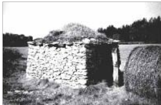
Foto 1. Barraque de planta cuadrada. En esta fotograf a puede apreciarse claramente el trabajo de confecci n del muro a base de piedras planas de forma irregular, colocadas sin ning n tipo de preparaci n previa. En las esquinas se colocan las piedras m s grandes para dar mayor solidez a la construcci n.(Calders – Bages)
