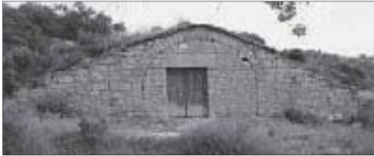
Cabaña cubierta con bóveda de cañón
