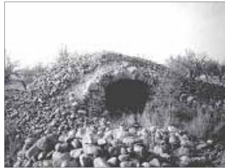
7.- Chozo. Aldeanueva de Ebro. Superior: Detalle bóveda corrida con lajas de arenisca trabadas "a seco". Inferior: Perspectiva del chozo.
