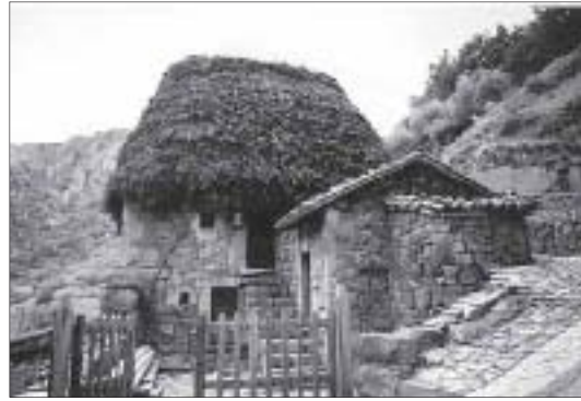
Lámina 9. Construcción-bloque en altura y cubierta de escoba de una braña vaqueira, con la cocina y el horno de pan adosados y cubiertos de teja
