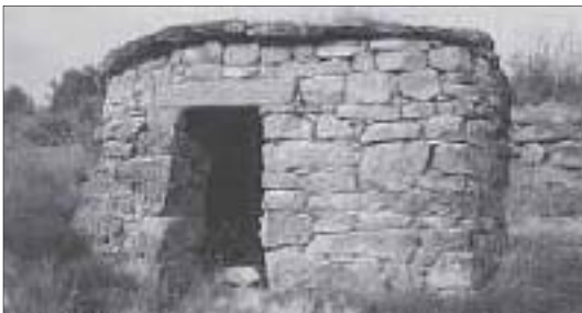
Cabaña cubierta por eliminación de ángulos
