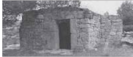
Cabaña cubierta con arco, jacenas y losas
