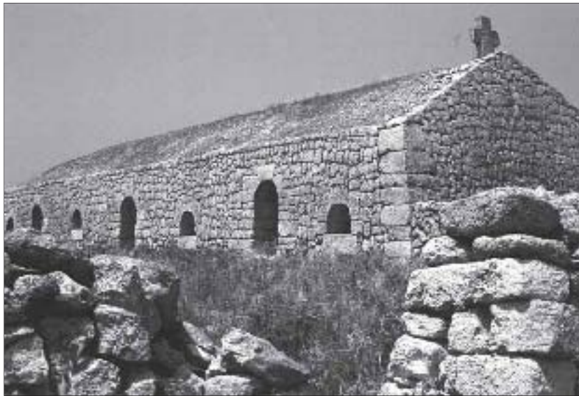
6. La aridez y la cantidad de piedra en superficie impulsó a los propietarios y payeses de las explotaciones de la zona norte del término de Ciudadella a dedicarse a la ganadería ovina intensiva, a la cual van destinadas sus construcciones en piedra seca. En la imagen se aprecia un pont en primer término, y dos barraques en el fondo.
