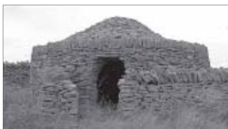
Iglesuela del Cid. Caseta con falsa cúpula por aproximación de hiladas dentro del Conjunto incoado BIC.
