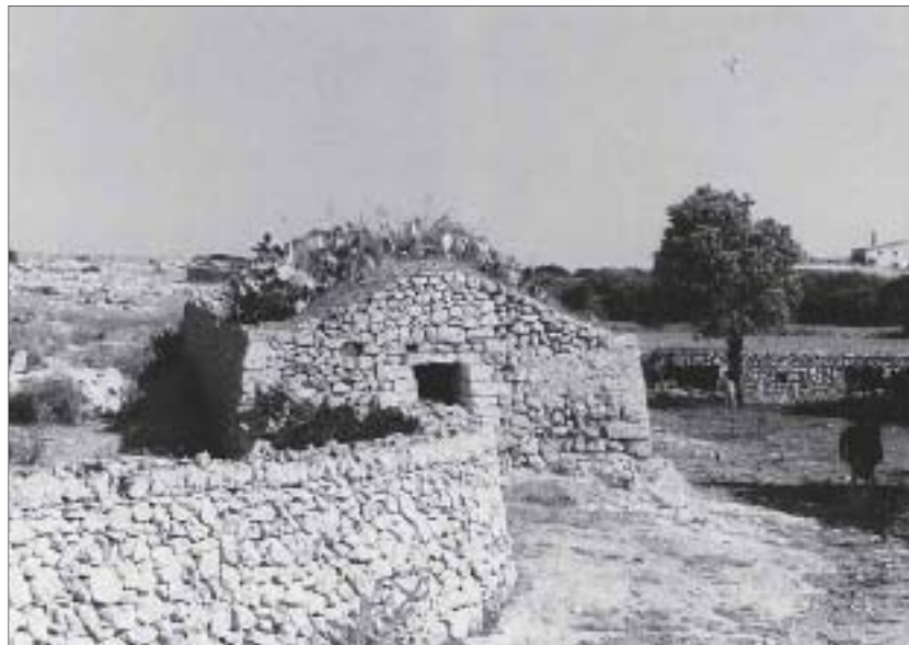
8. Los ponts convencionales son de planta rectangular con un acceso orientado en dirección sur, techo de losas de piedra arenisca a doble vertiente y relleno de tierra o piedra pequeña. El ejemplo de la imagen, como es muy frecuente, se encuentra adosado a una paret seca , con el fin de dejar el máximo espacio libre en la tanca para cultivarla cuando llegue el momento
