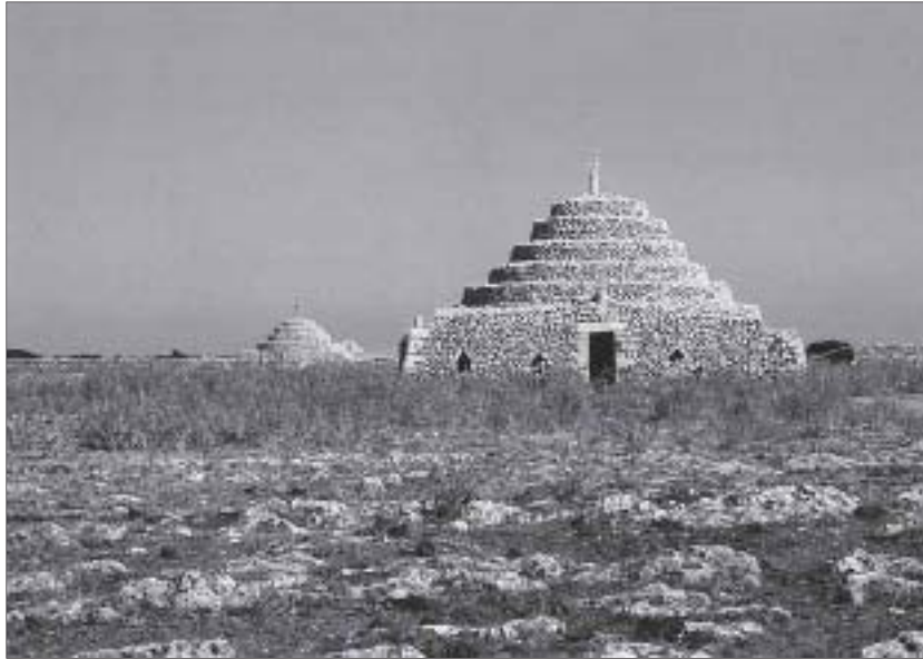
5. “Es pont de sa Creu”, en tierras de la explotación de Son Salomó (Ciudadella de Menorca). Se trata de un raro ejemplo de arquitectura en piedra seca con piedras perfectamente labradas y ensambladas y cubierta del espacio interior con bóveda de cañón.
