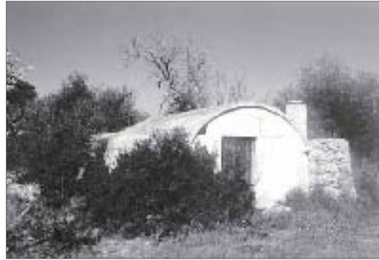
Barraca de establidor con cubierta de bóveda de medio cañón
