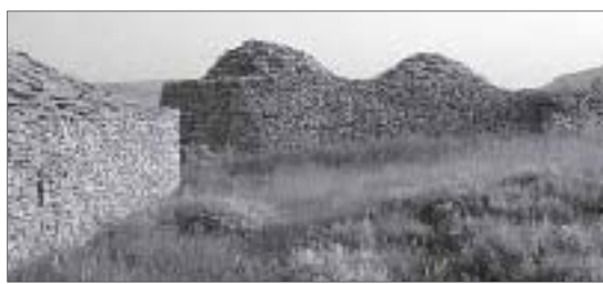
Mosqueruela. Caseta con dos falsas cúpulas por aproximación de hiladas.
