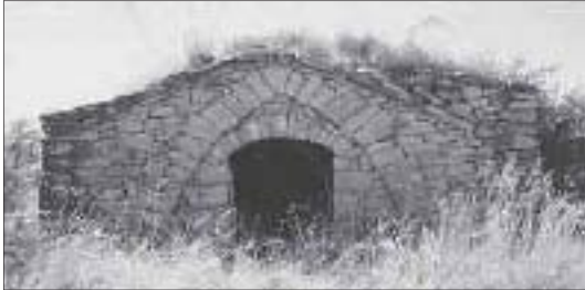
Cabaña cubierta con bóveda apuntada
