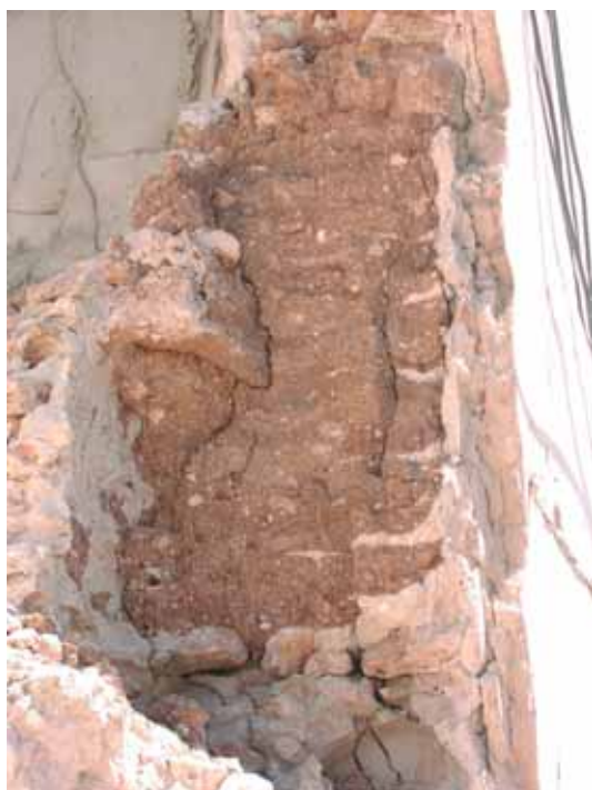
Sección de tapia con costra sobre la que se ha aplicado un revoco posteriormente (Villarrobledo)
