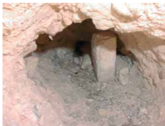
Detalles de medias agujas clavadas en un orificio del muro (Jorquera)
