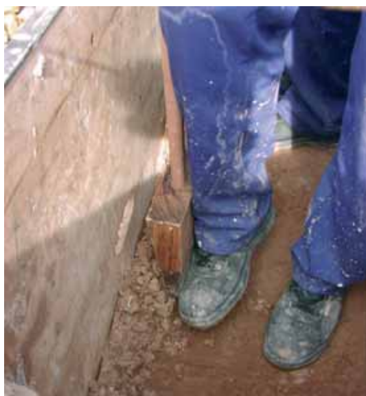
Detalle de ejecución de costra durante la construcción de una tapia (Escuela Taller de Almansa)
