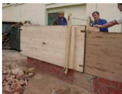
Desplazamiento del tapial. Escuela Taller Castillo de Almansa (2003)
