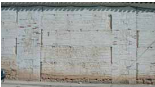
Fábrica mixta de ladrillo y tapia
