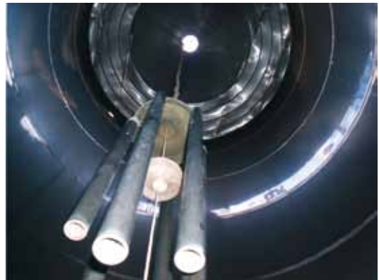
Móvil tubular en depósito de acero. Nº 46
