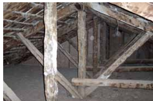
Cerchas de sustentación de la cubierta. Venta del Pesquete
