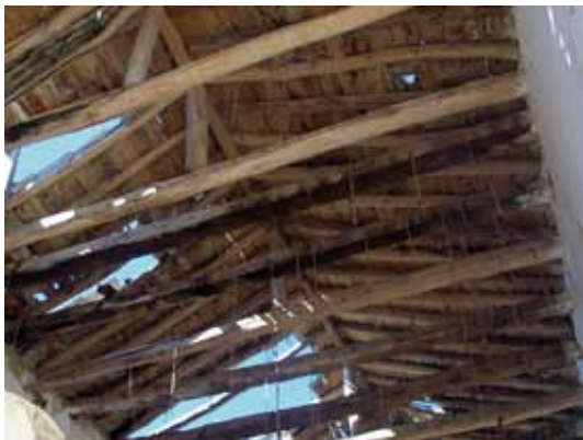
Entrevigado realizado con entablado de madera. Vivienda de los Nuevos
