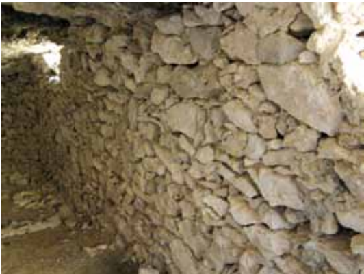
Fábrica de piedra viva. Cantos muy pronunciados. Muro en una cavidad de la montaña. Alcozarejos
