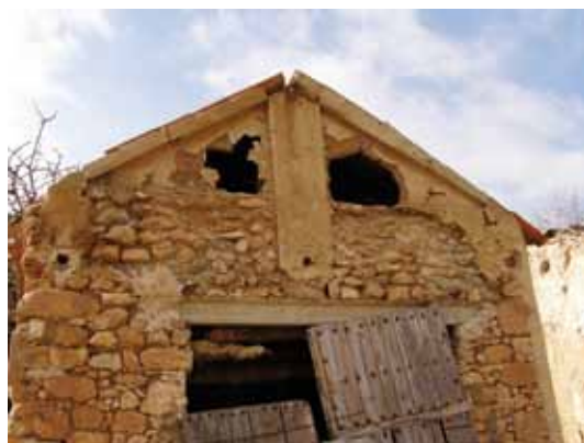
Muro piñón. Viga cumbreira apoyada en machón de adobe. Relleno de adobe. Aldea de Puente Torres
