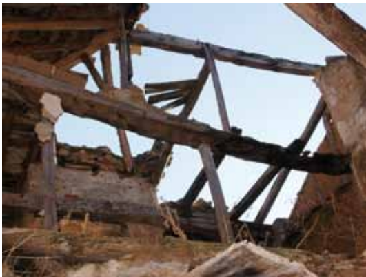
Vista interior de la cubierta de la vivienda de Los Nuevos
