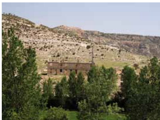
Vista desde la antigua central hidroeléctrica
