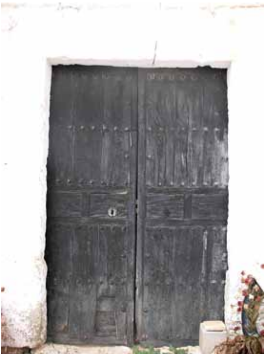
Puerta Ermita del Cementerio. Rubielos Bajos
