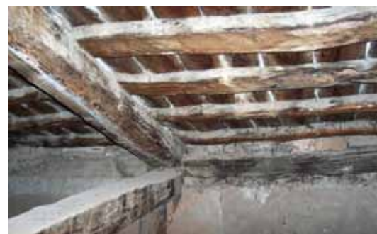
Enlace de cercha sobre durmiente. Viguetas de madera y entablado. Venta del Pesquete. La Pesquera
