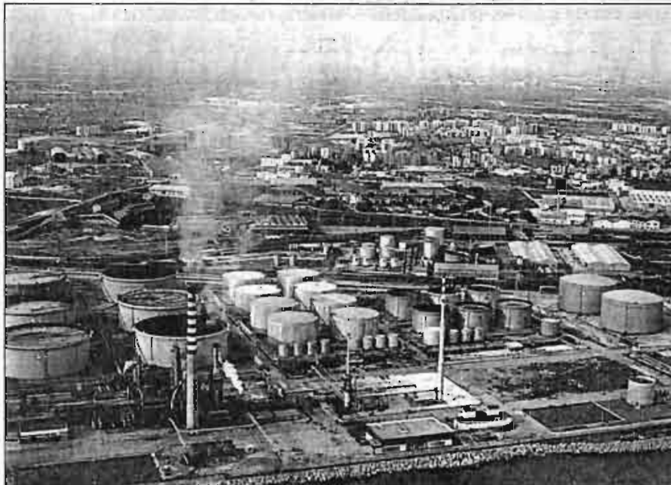
El 27% de las áreas contaminadas por las actividades industriales se encuentran en suelo urbano.
