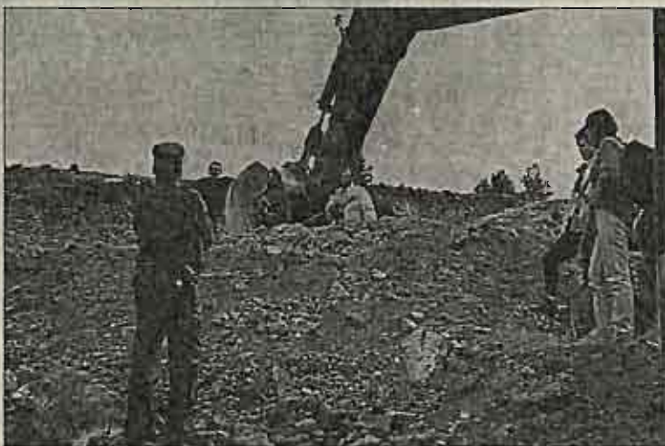
Vertedero de La Rambla, cuando fue ocupado por los ecologistas para exigir la paralización de las obras. / FOTO LA VERDAD
