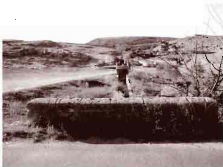
Los puentes de La Hiedra de Alpera, donde nace el trasvase que lleva el agua a Almansa
