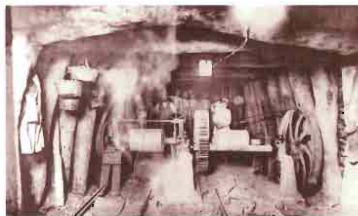
Azufrera del Coto de Hellín. Plano inclinado en la Galería de Transporte
