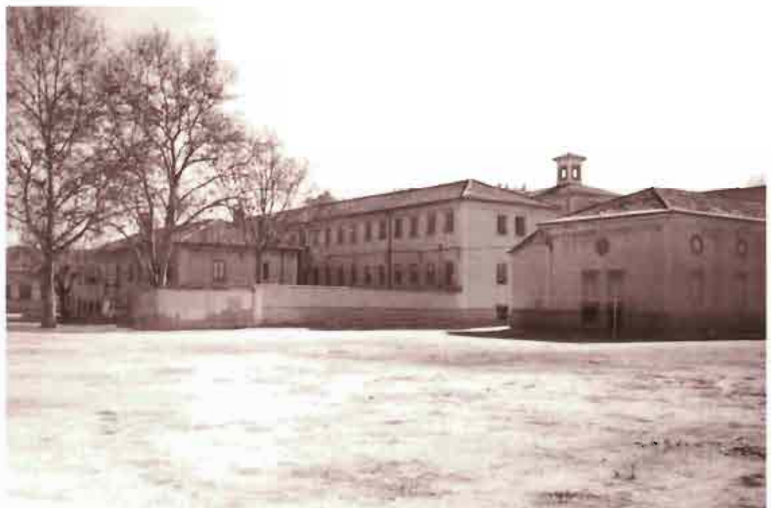
Centro “Giner de los Ríos”. El teatro y otras dependencias desde la parte posterior del solar. (Foto de la autora)
