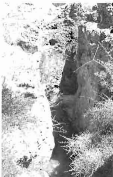
Fot. 6: Aliviadero excavado en la roca de uno de los baranes de la laguna Lengua.
