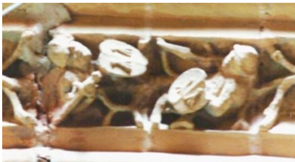
Foto 10. Cara interior de la portada de la capilla del Rosario. Detalle. Fot. J. S. Ferrer.
