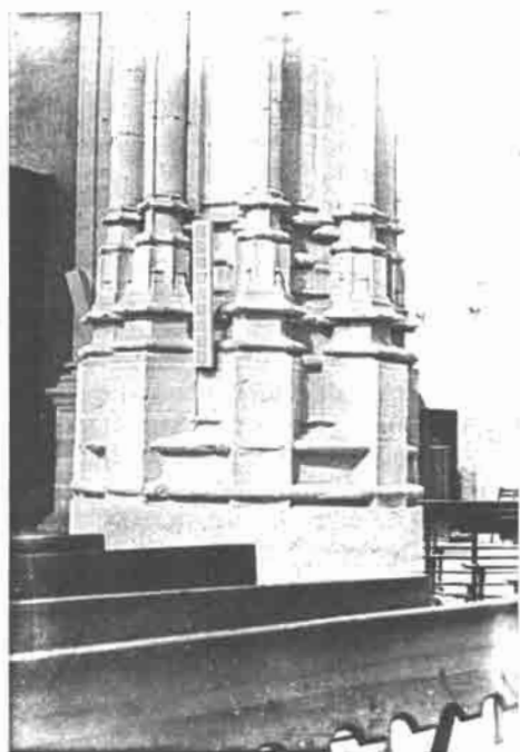
Figura 8.- Basa de Pilar. San Blas. Villarrobledo.
