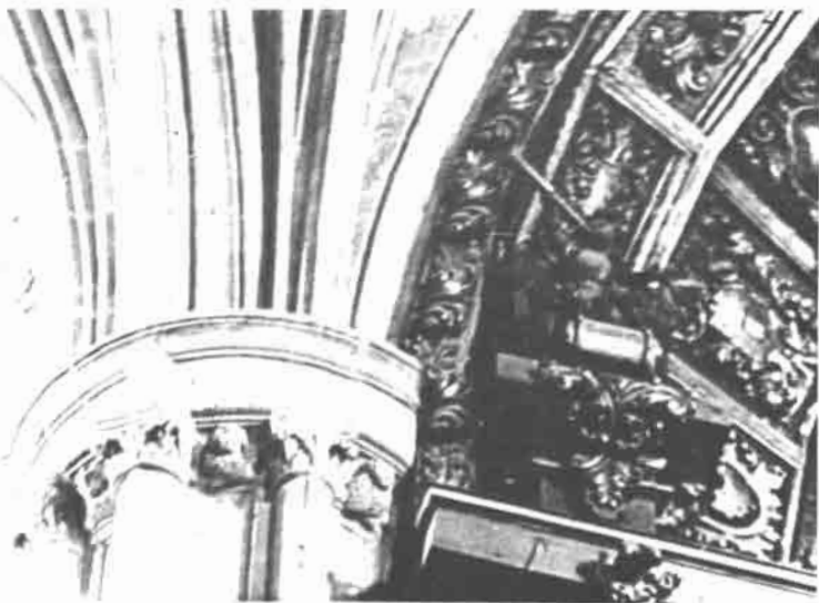
Figura 10.- Detalle de un pilar adosado a la cabecera. S. Blas. Villarrobledo.
