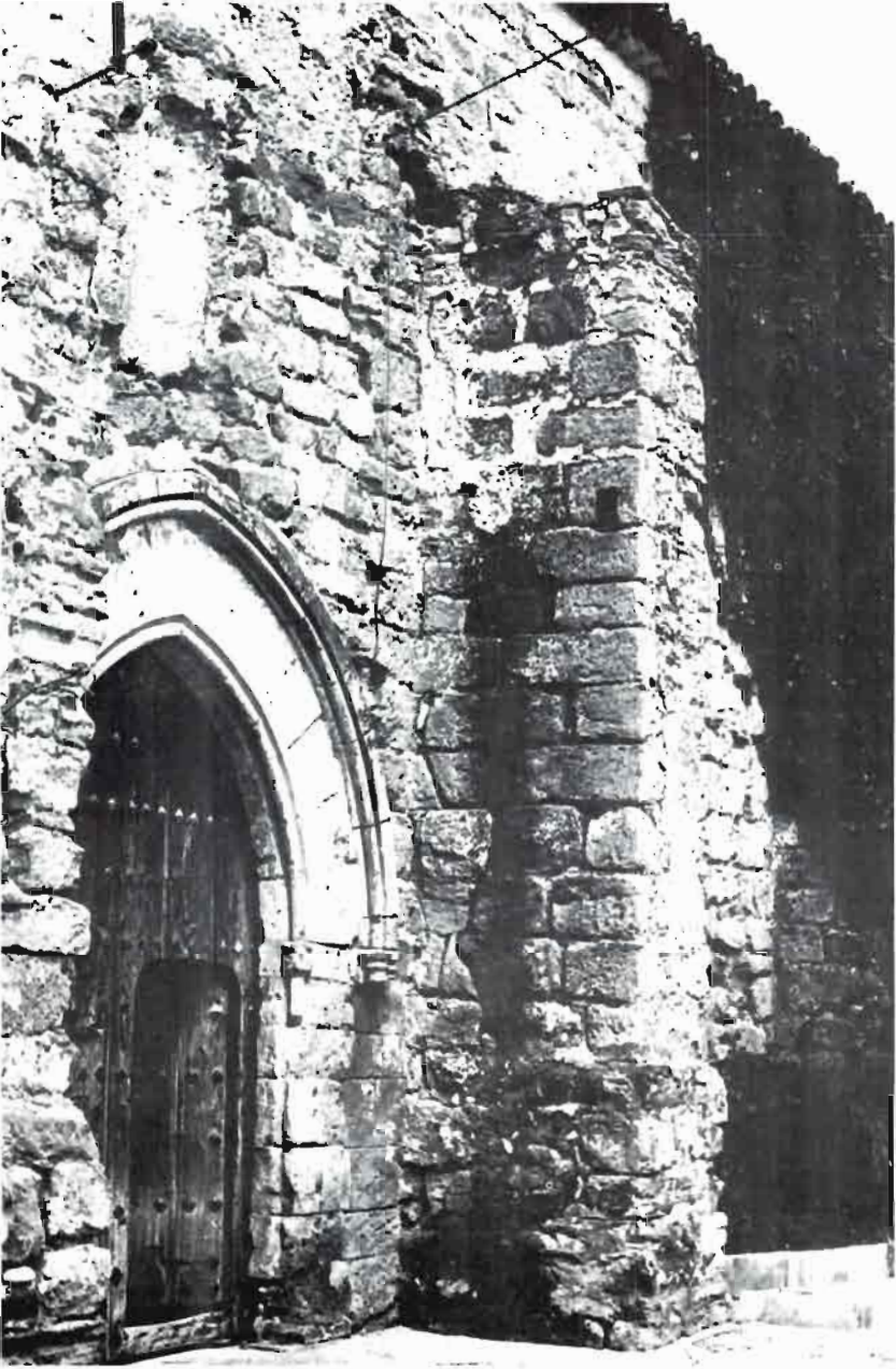
Puerta de ingreso.
