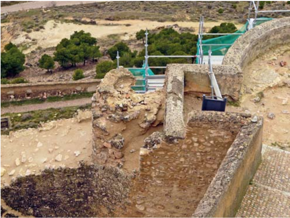
Fig. 9. Restos de la garita de vigilancia del penal existente junto a la entrada SW.
