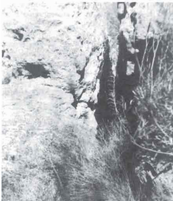
Conducción de agua excavada en la roca. Los Batanes (Alcaraz).
