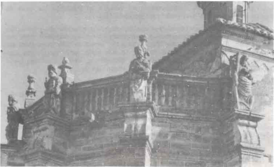
Fig. 8.- Santa María de Chinchilla. Balaustrada superior del ábside.
