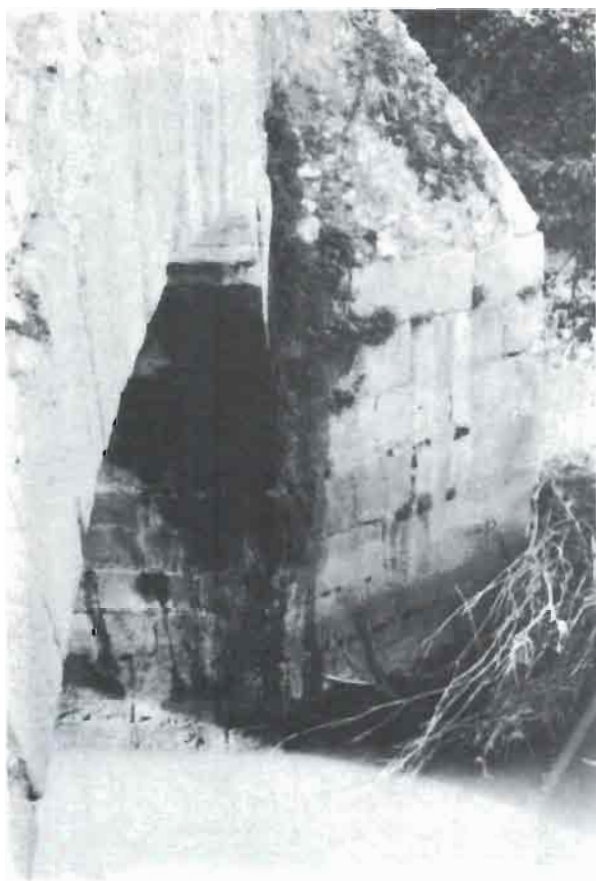
Puente número 1.- Vista del tajamar occidental. (Aguas arriba)
