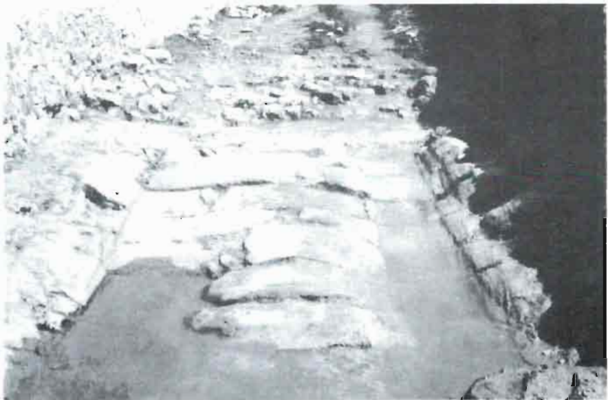
Puente número 1.- Vista de la calzada romana al tercer día de trabajo. Obsérvese el cambio de pavimento en la parte superior.
