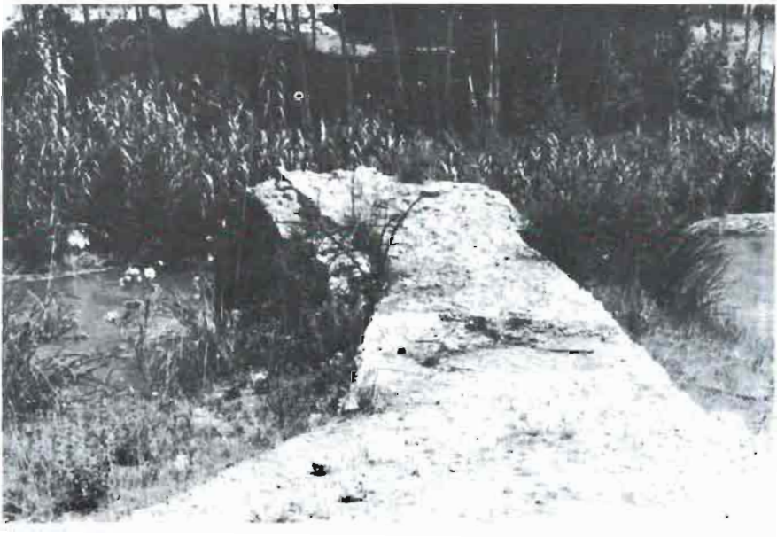
Puente número 2.- Vista Sur del puente. Obsérvese el camino formado por la argamasa y los cantos rodados. Se trata de una verdadera calzada.
