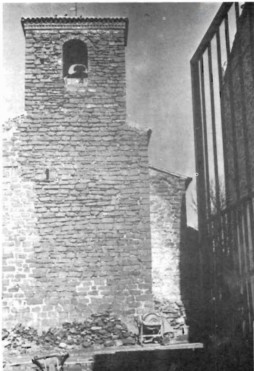
Torre de la iglesia.
